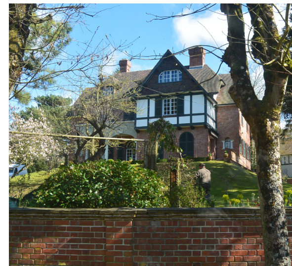
Parement mixte : brique, faux pans de bois...
